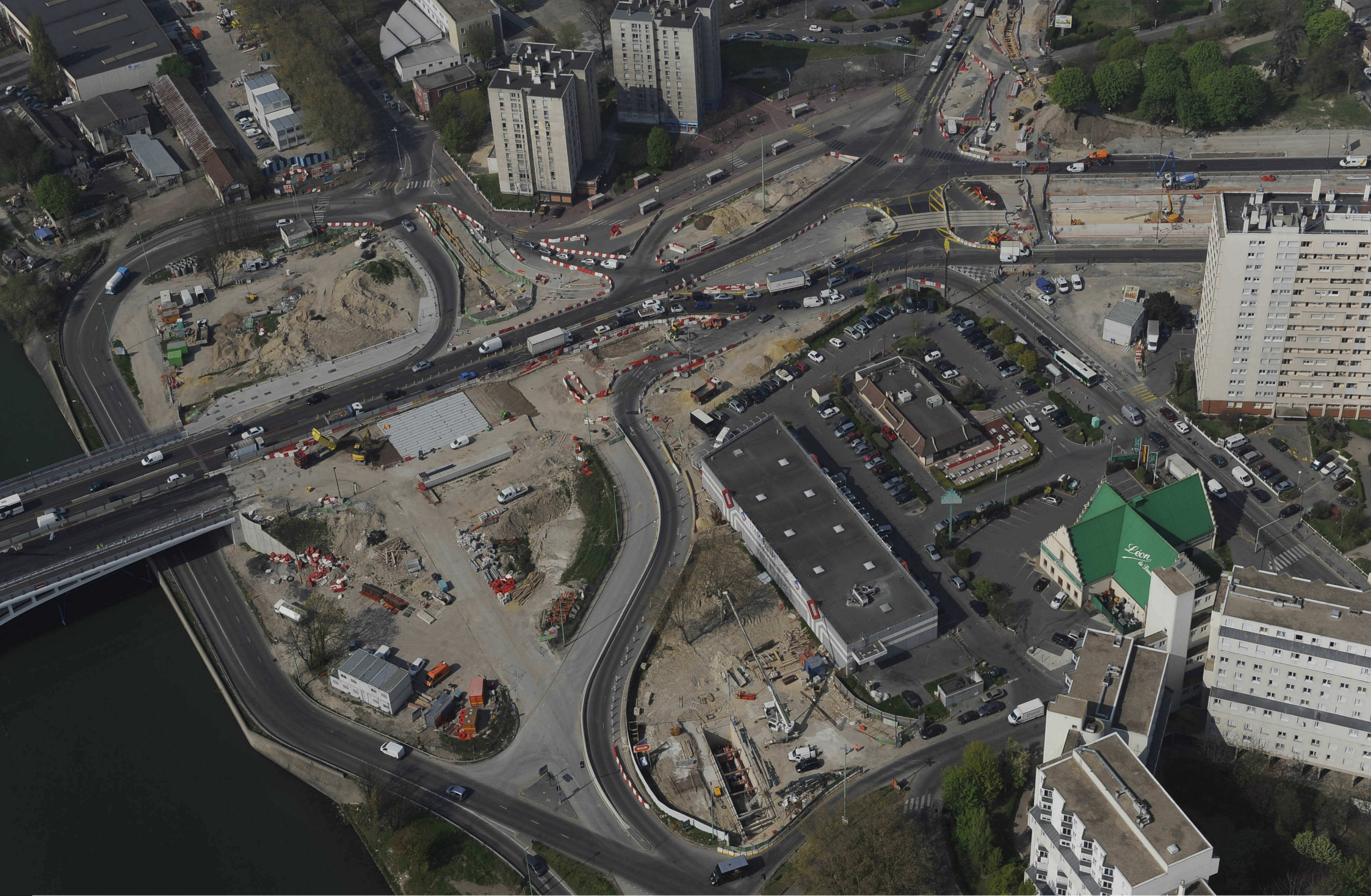
avril 2010 – Bezon – travaux d'aménagements urbains : réalisation des mesures conservatoires pour le pont Dalle – CP : CG92
